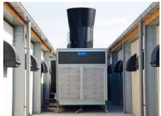
Elke stal heeft een warmtewisselaar met kachel. Dat moet zorgen voor een goed klimaat
