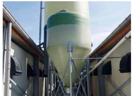
Er is rekening gehouden met de omgeving: de silo's staan tussen de stallen en vallen zo minder op
